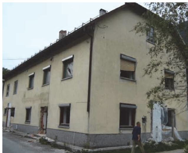
Slika 8. Sjeverna i zapadna fasada zgrade
