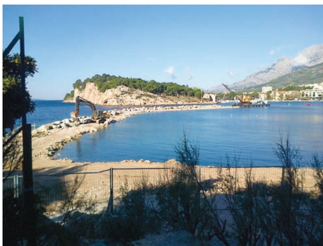
Uznapredovali radovi na gradnji prve faze lukobrana
