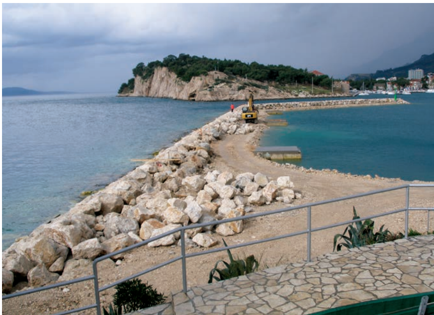
Pripreme za završetak prve faze lukobrana
