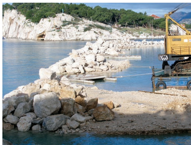
Ugradnja propusta u tijelo lukobrana
