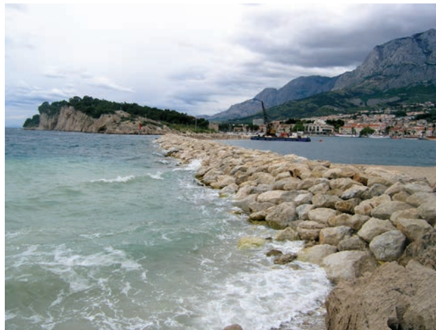
Valovi se odbijaju od novog lukobrana
