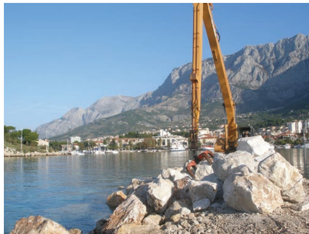
Ugradnja kamenometa
