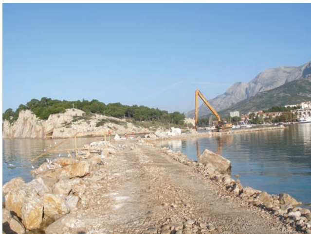
Radovi na nasipu lukobrana
