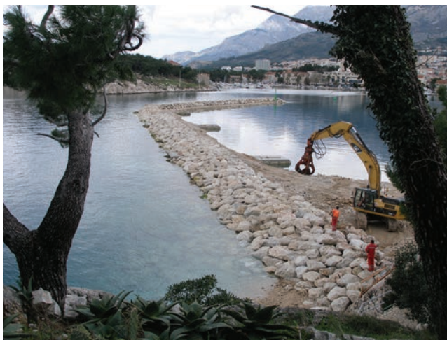
Završetak prve faze lukobrana
