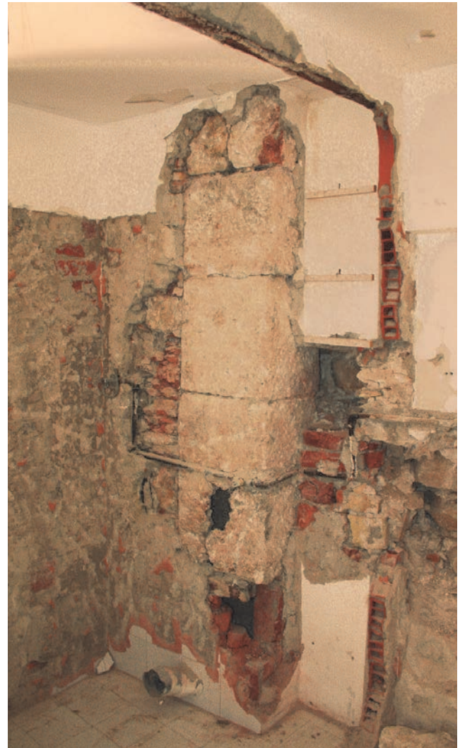
Slika 19. Antička odvodna vertikala od kamenih cijevi pronađena 2013. u antičkom zidu istočne građevine sjevernog dijela Palače (u ulici Julijusa Nepota 1)
