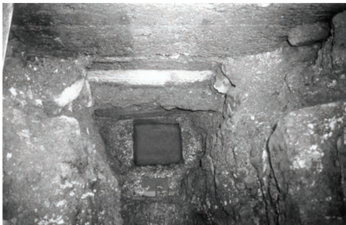
Slika 13. Izvorna revizijska okna (Urbanistički zavod Dalmacije)
