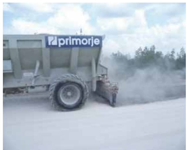
Slika 5. Posipanje drobljenog kamena cementom
