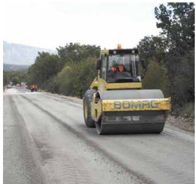
Slika 6. Predzbijanje reciklirane mješavine
