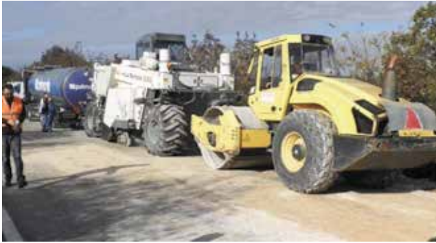
Slika 3. Reciklažni vlak na gradilištu
