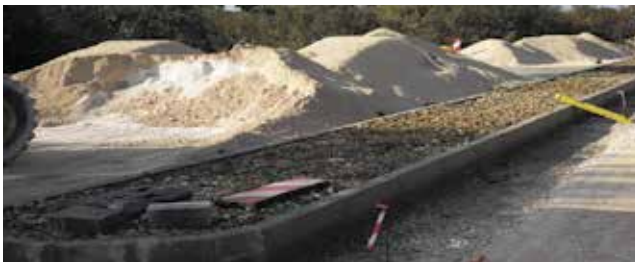
Slika 1. Deponiranje drobljenog kamenog materijala 0/4 mm na gradilištu
