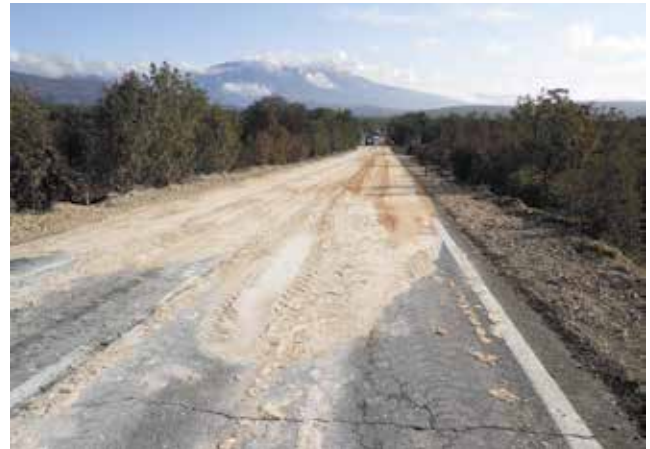
Slika 4. Posipanje postojećeg kolnika drobljenim kamenom
