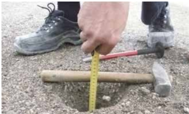
Slika 7. Kontrola debljine nosivog sloja kolničke konstrukcije
