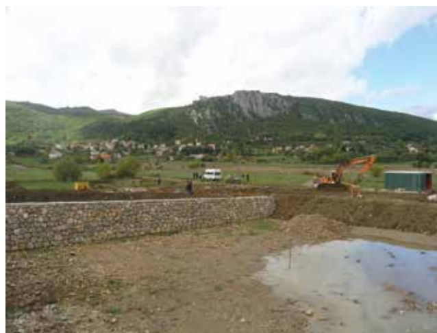
Pogled s nasipa na gradilište i Vrliku
