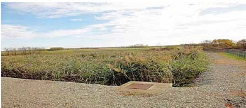
Jedan od bazena za pročišćavanje u Vinogradcima
