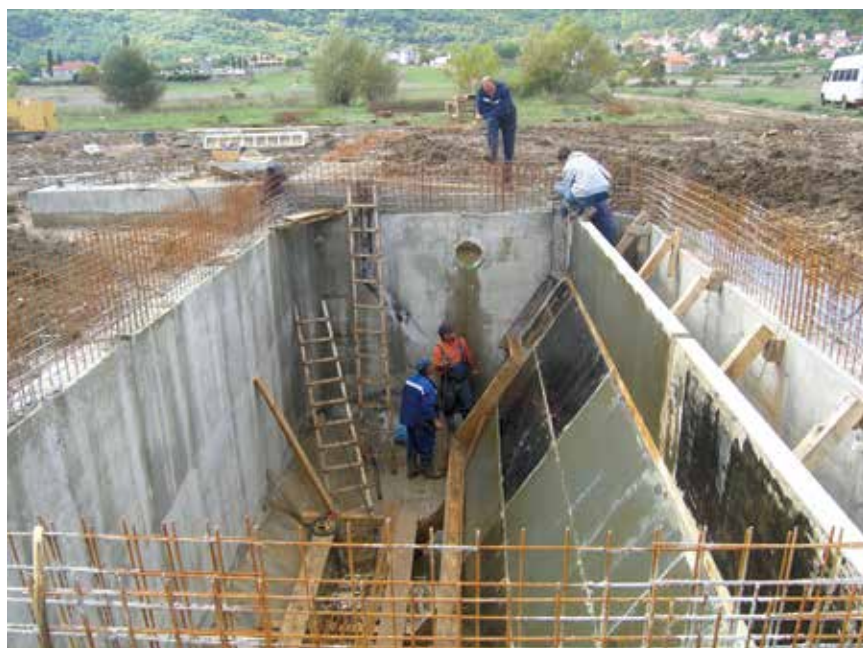
Gradnja taložnice na vrličkom biljnom uređaju
