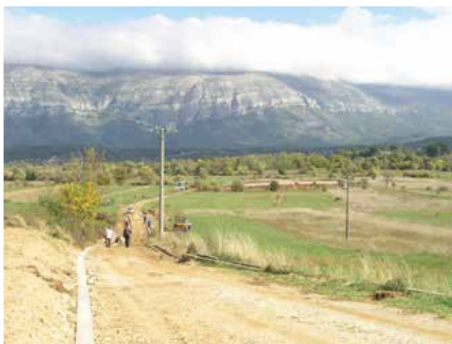
Pristupna cesta i biljni uređaj u gradnji
