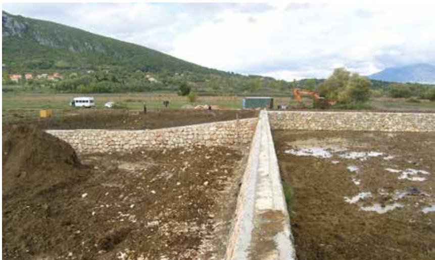
Pregradni zidovi bazena obloženi kamenom
