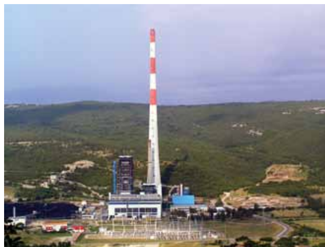
Postojeća termoelektrane Plomin 2
