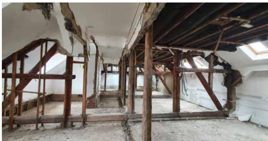
Radovi na obnovi krovišta
