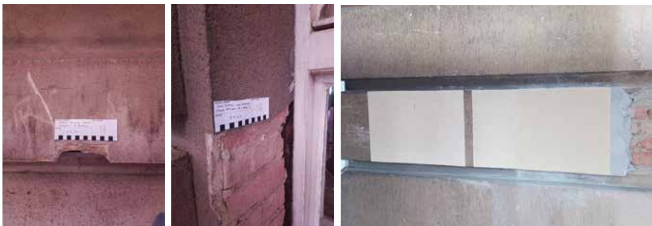
Ulična će pročelja u cijelosti biti sanirana u skladu s konzervatorskim smjernicama, uzimanje uzoraka fasadne žbuke prema kojima će se odrediti granulacija i boja fasade
