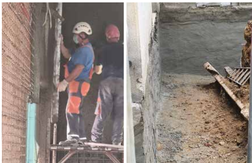
Detalji s gradilišta
