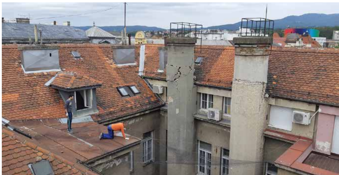
U sklopu hitne sanacije neposredno nakon potresa na zgradi su izvedeni neophodni radovi rušenja i uklanjanja dvaju dimnjaka sa sjevernoga zida
