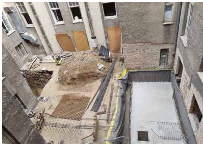
Radovi u unutrašnjem dvorištu za izradu dizala
