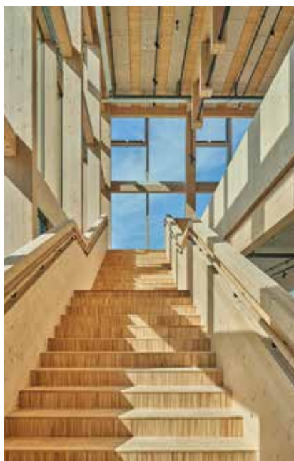
Neboder u Skellefteåu u potpunosti je izgrađen od drva iz lokalnih šuma
