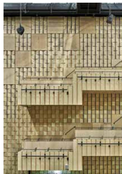
Korištenjem drvenih elemenata značajno je smanjen ugljikov otisak zgrade
