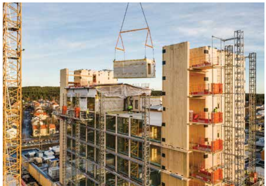
Detalj snimljen tijekom montaže konstrukcije
