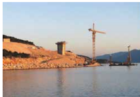
Slika 4. Gradilište mosta Pelješac 2009. godine
