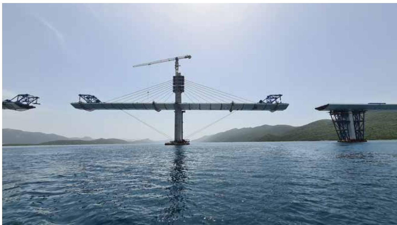
Slika 14. Montaža rasponskog sklopa – pilon S10
