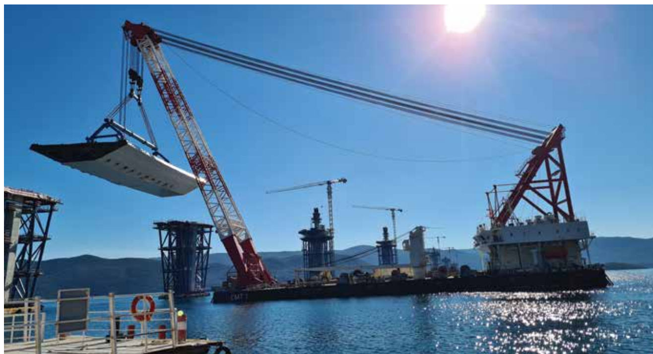
Slika 12. Montaža elemenata pristupnih raspona
