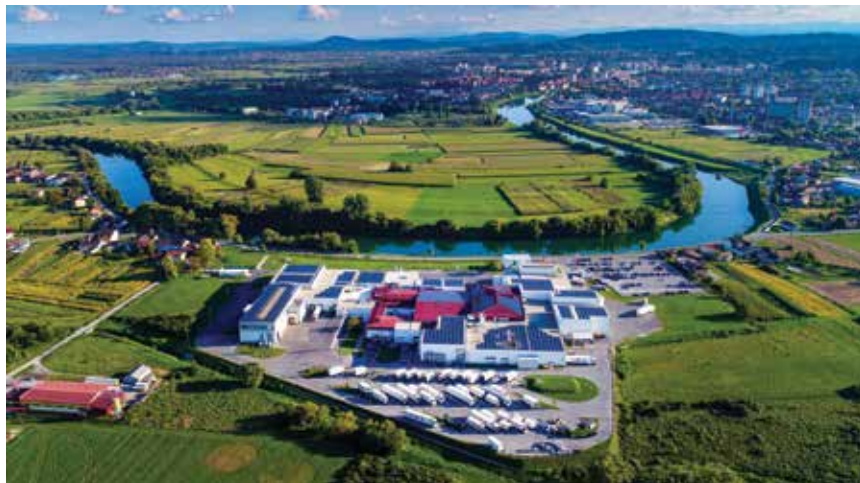
Sunčana elektrana u Karlovcu prvi je projekt iz programa HEP EE Solar Plus koji se odnosi na investicije u energetske učinkovitost i obnovljive izvore energije za industrijske objekte
