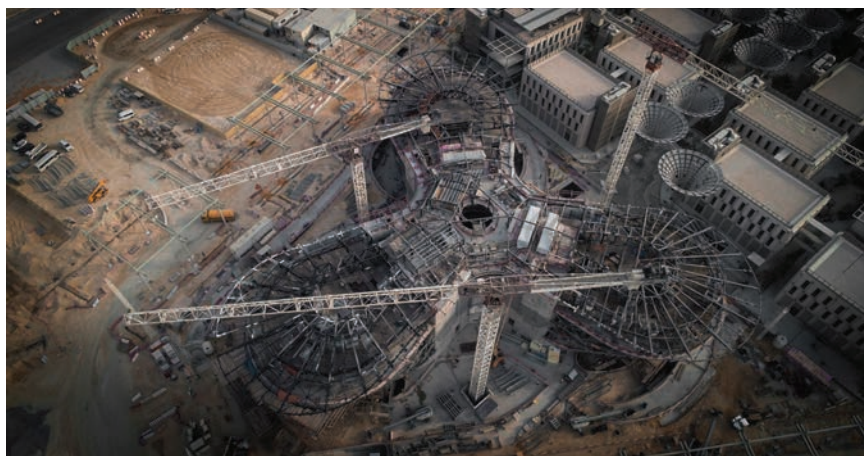
Pogled na gradilište tematskog paviljona Mobilnost
