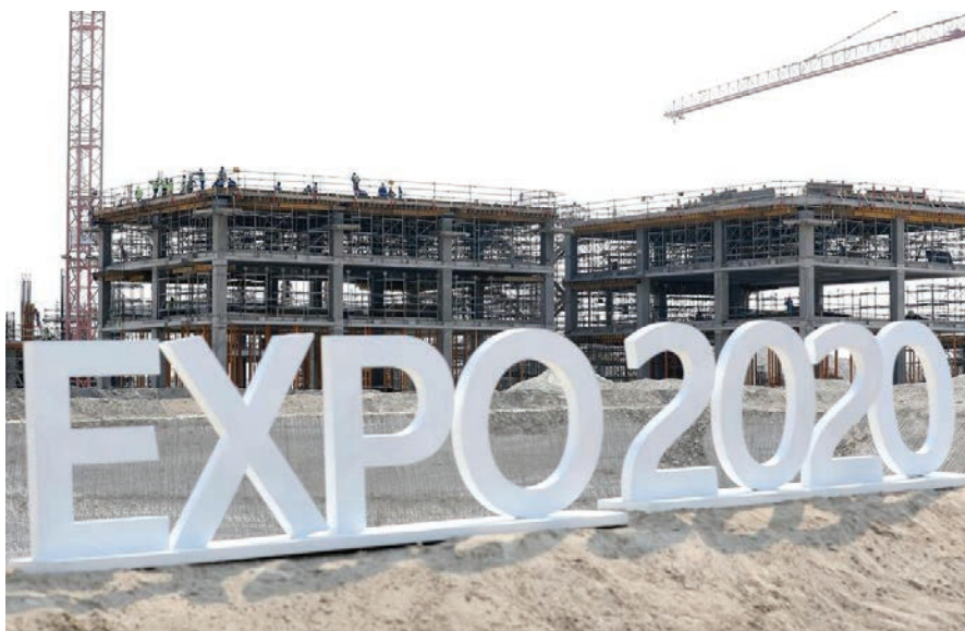
Detalj s gradilišta EXPO City 2020.
