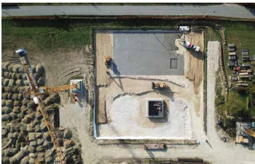
Pogled na gradilište
