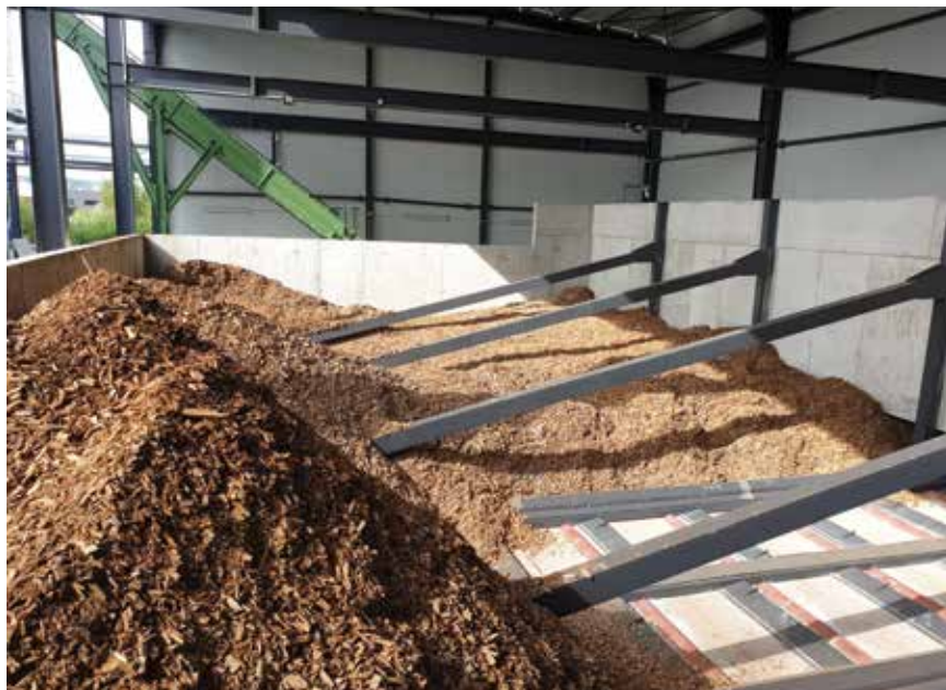
Drvena sječka u spremniku
