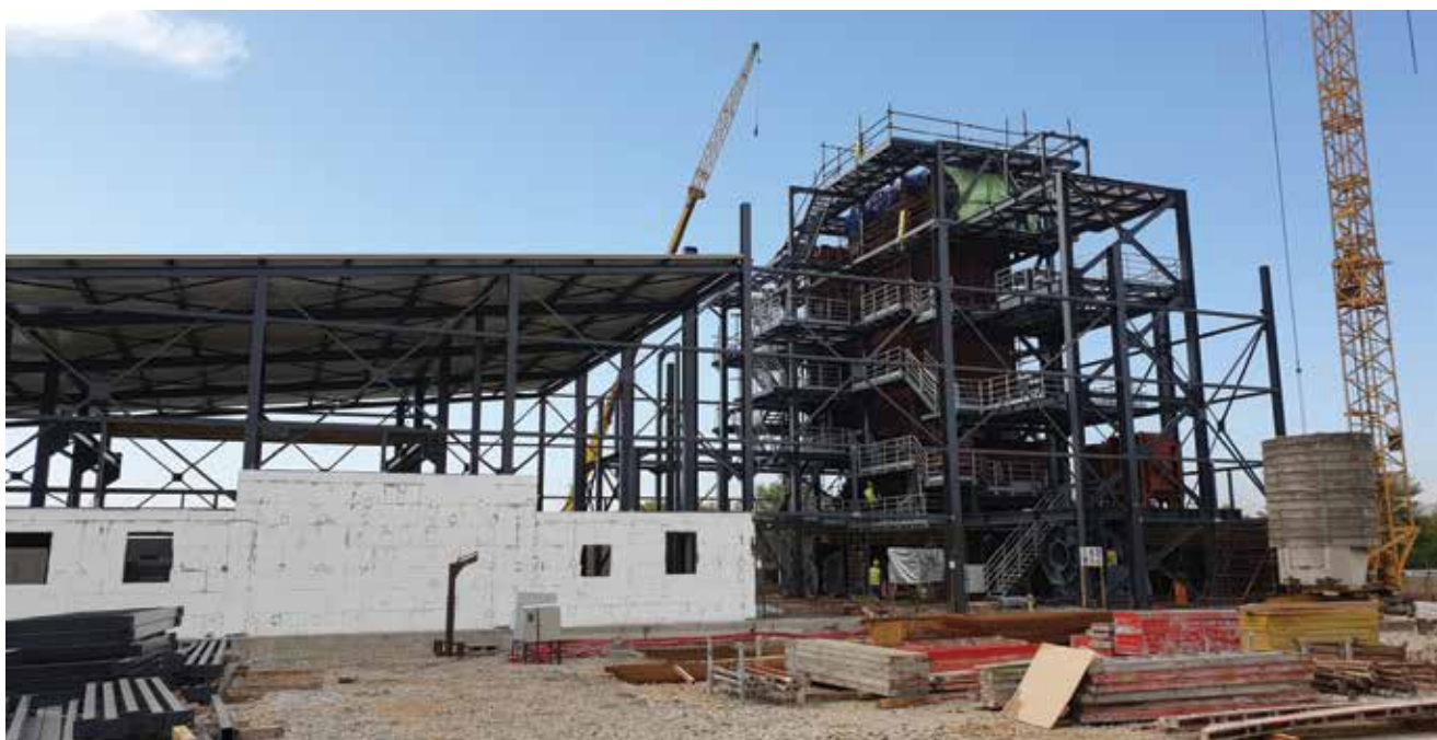
Pogled na gradilište
