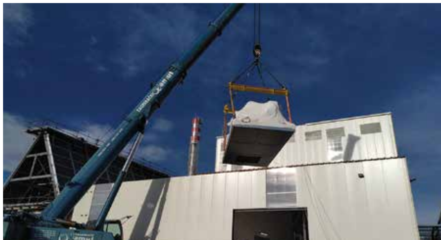
Montaža turbine kroz krovnu konstrukciju
