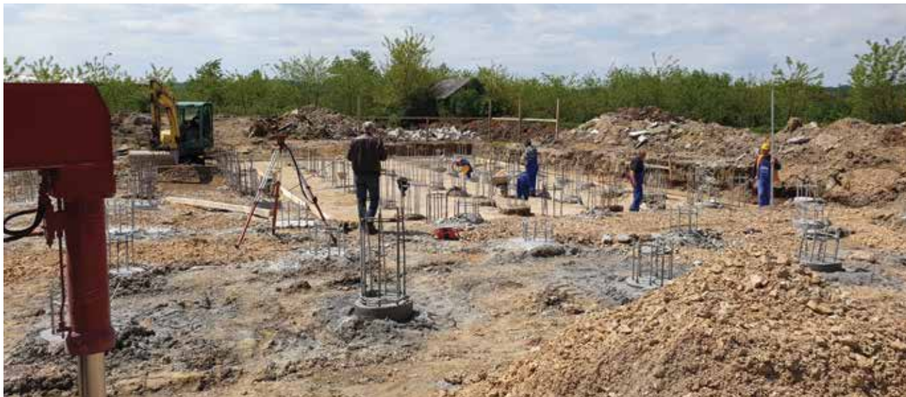
Izvedba pilota za potrebe temeljenja građevine
