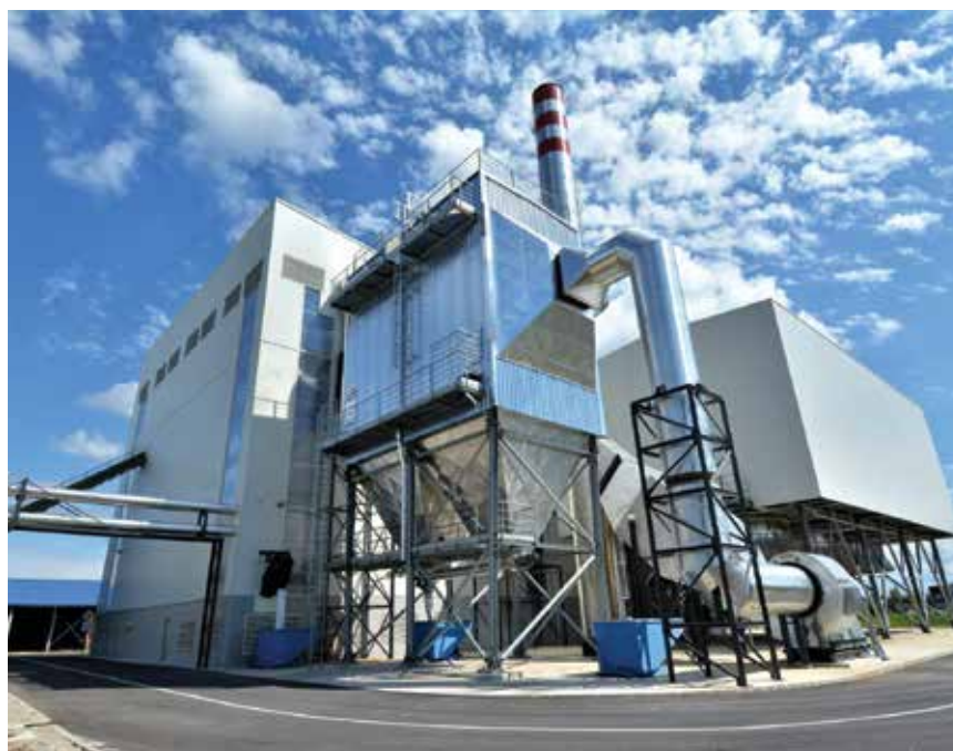
Bioelektrana – toplana u Karlovcu snimljena nakon završetka svih radova
