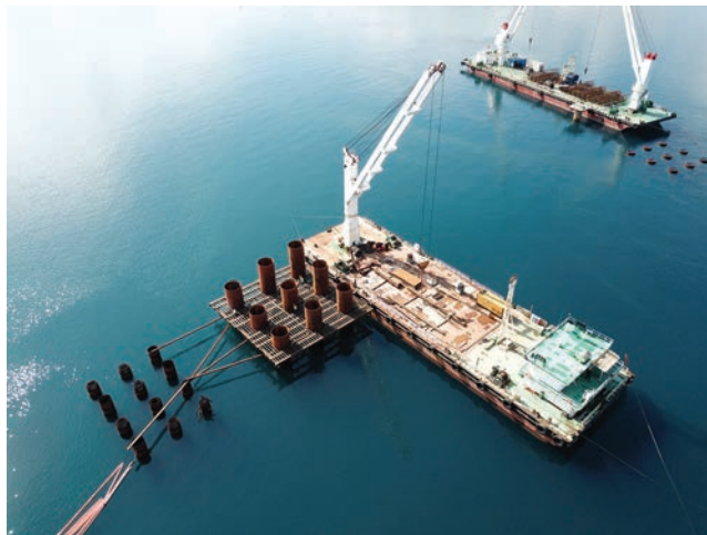
Na gradilištu je zabijeno ukupno 148 stalnih pilota
