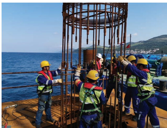
Ugradnja armaturnih koševa na stupnom mjestu
