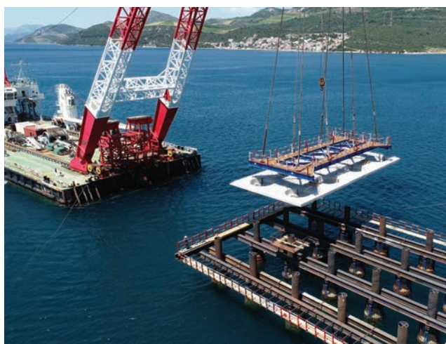
Pripremni radovi za betoniranje naglavnice pilota
