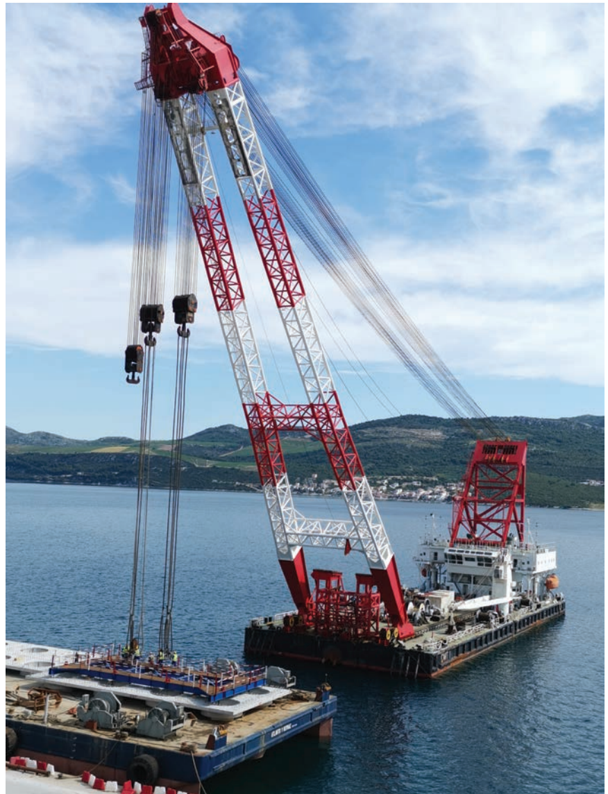
Detalj s gradilišta
