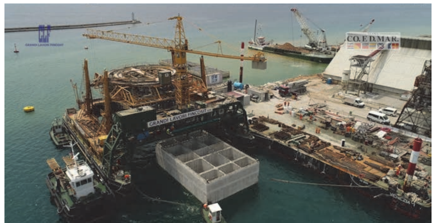
Slika 16. Plutajuće postrojenje za proizvodnju kesona
