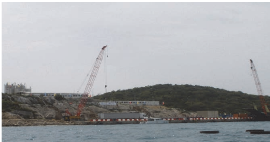
Pogled na gradilište Pelješkog mosta
