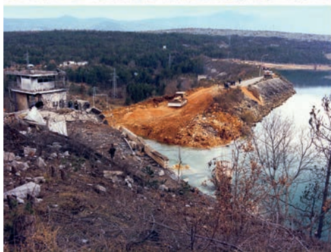
HE Peruča - brana, akumulacija i strojarica – sanacija nakon miniranja 1993. godine
