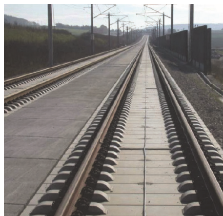
Slika 5. Kolosijek na čvrstoj podlozi Bögl (željeznička linija Nürnberg-Ingolstadt, 2006.)
