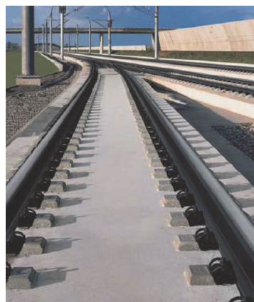
Slika 4. Kolosijek na čvrstoj podlozi Rheda 2000
