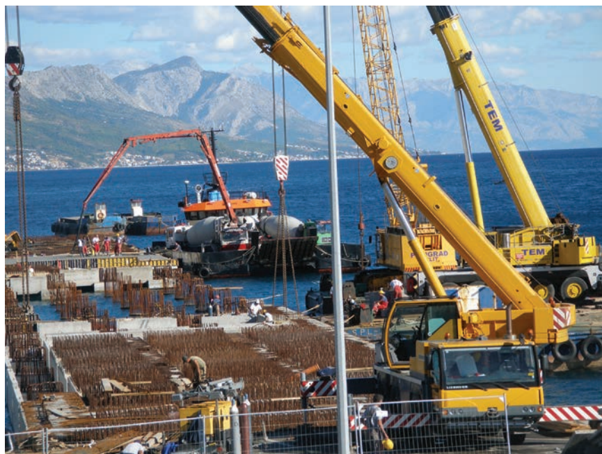
Radovi na ugradnji betona i montaži elemenata lukobrana
