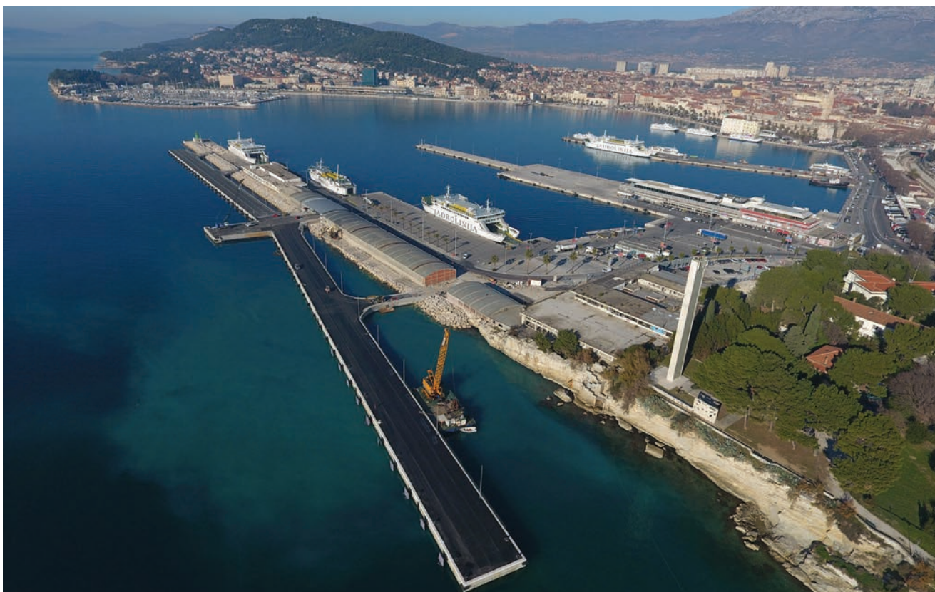
Pogled iz zraka na gradilište
