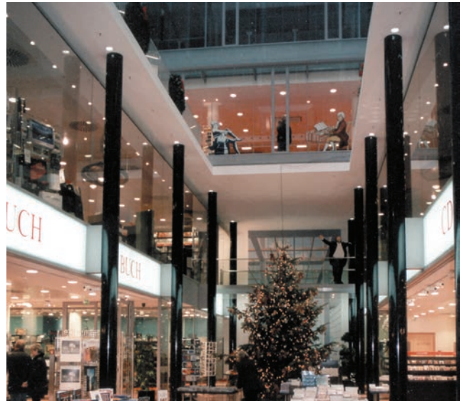
Slika 7. Trgovački centar Dussmann, Berlin Geilinger-Stützen® Ø 273 mm
