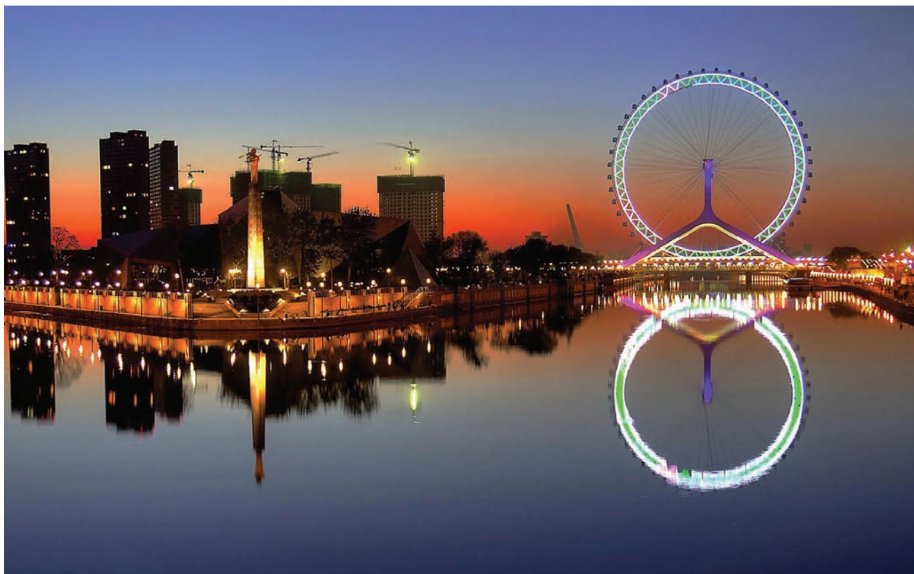
Pogled na Tianjin i gradilišta novih poslovnih zgrada
