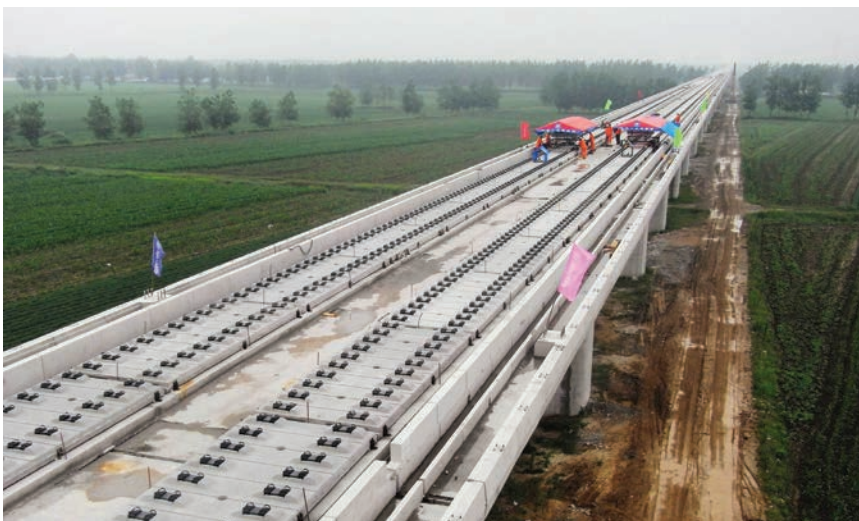
Detalj s gradilišta nove željezničke pruge za brze vlakove
