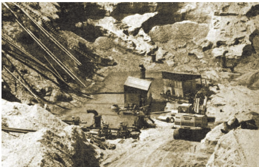
Radovi u građevnoj jami (iz reportaže)
