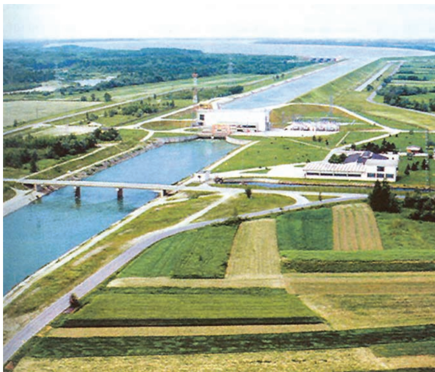
Pogled na branu, strojarnicu, derivacijski kanal i jezero u pozadini
