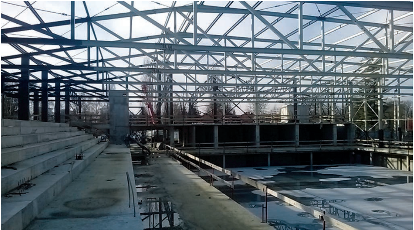
Radovi na montaži čelične konstrukcije
