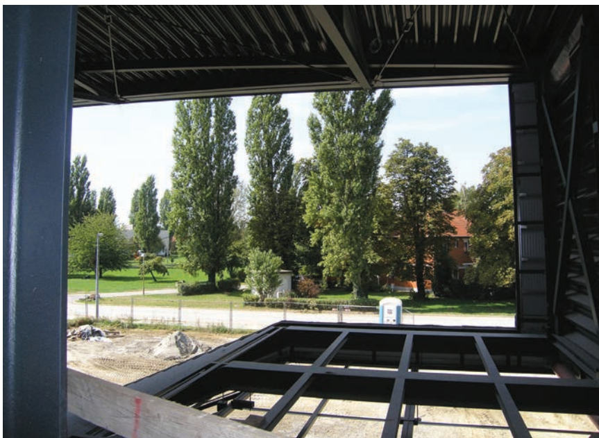
Pogled kroz otvor u čeličnoj konstrukciji
