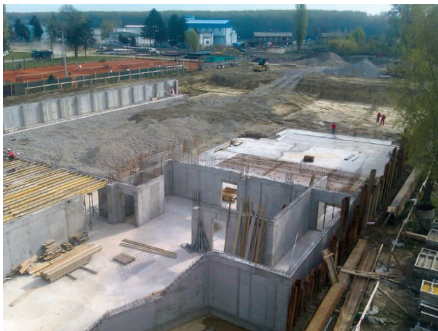
Početak armiranobetonskih radova
