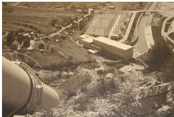
Slika 6. Hidroelektrana s otvorenim tlačnim cjevovodom 1970-ih godina
