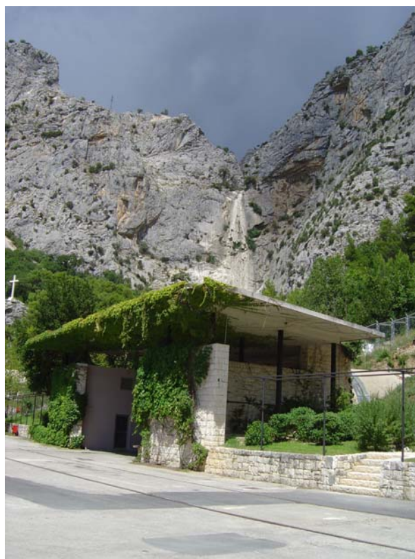
Slika 2. Portal pristupnog tunela
