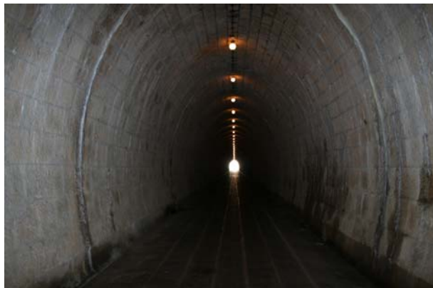
Slika 13. Pristupni tunel strojarnici hidroelektrane „Vinodol“ danas
