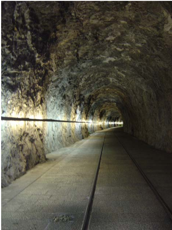
Slika 3. Pristupni tunel sa osvijetljenjem
