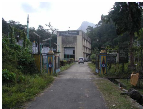
Slika 11. Hidroelektrana „Sholayar I
