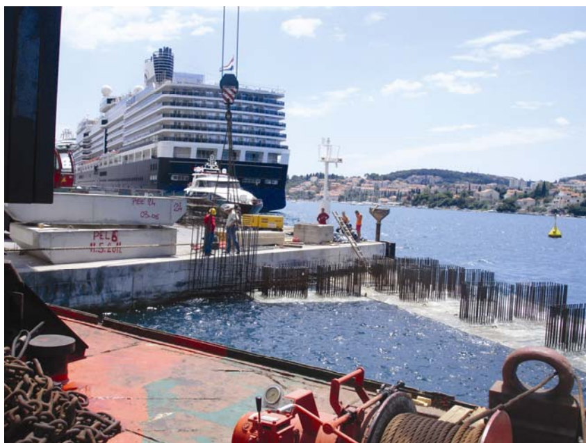
Izvedba zidova produženja vezova 16. i 17
