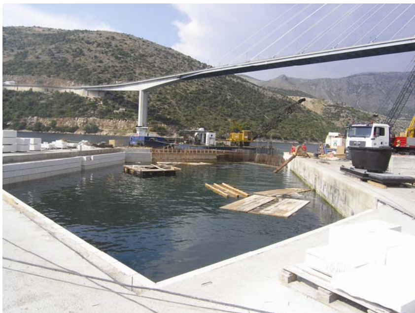
Radovi na obalnim zidovima tijekom posjeta gradilištu
