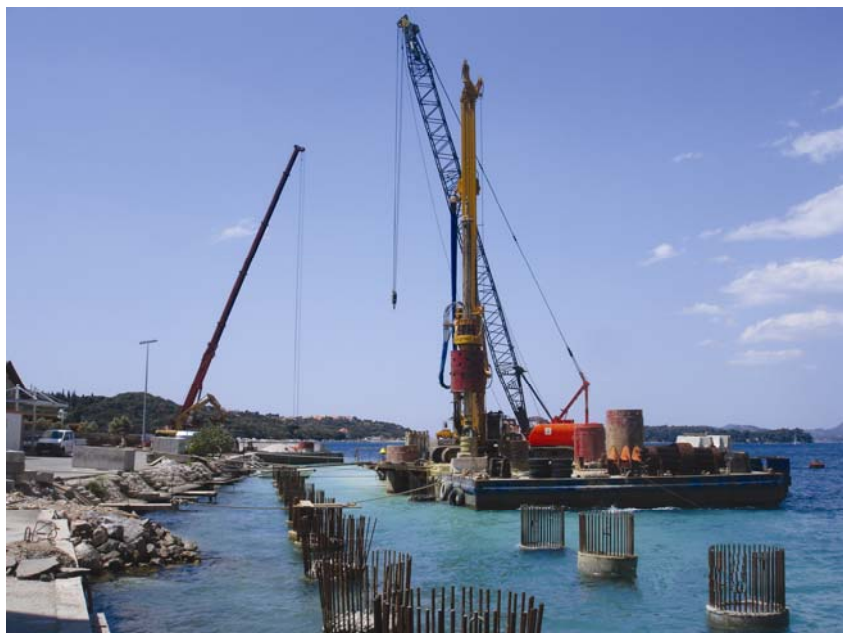
Bušenje i zabijanje prvih pilota
