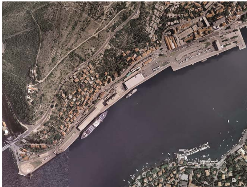
Pogled iz zraka na grušku luku prije početka radova
