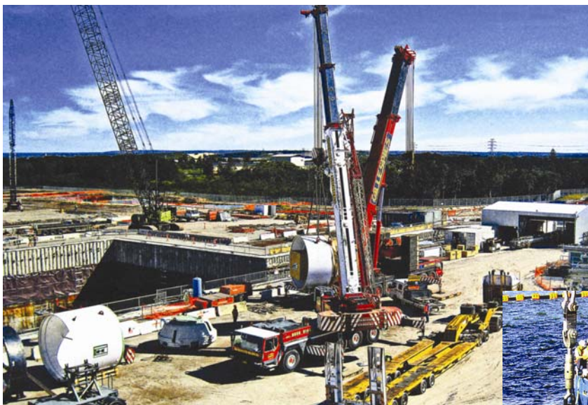
Gradilište tunela koji će spajati postrojenje desalinizacije s obalom Sydneya
