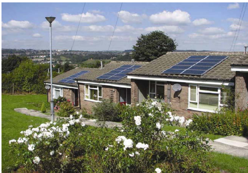
Kolektori u ravnini krovne plohe
