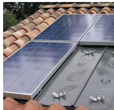
Postavljanje kolektora na nosače s kopčama
