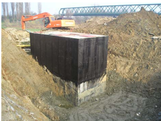
Slika 7. Završni radovi na crpnoj stanici CS1
