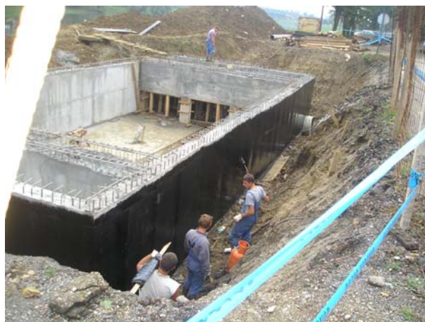
Slika 5. Betonski radovi na retencijskom bazenu u Pedišičevoj ulici
