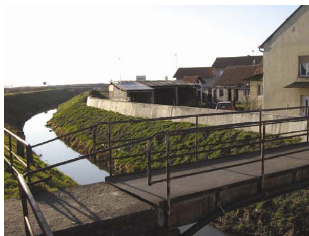
Slika 12. Armiranobetonski zid u stacionaži 7 + 672 ILK-a
