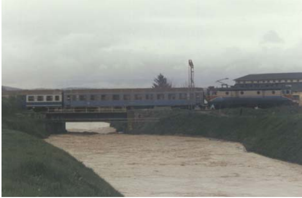
Slika 4. Željeznički most preko ILK-a za velike poplave u kolovozu 2005.
