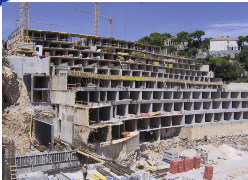
Pogled na gradilište u početku radova na novom hotelu
