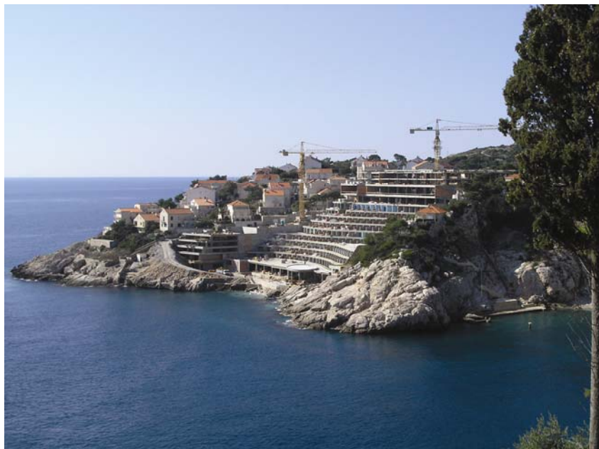
Pogled na gradilište hotela s Boninova
