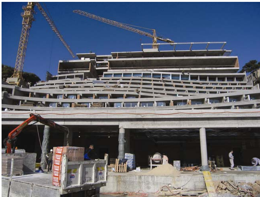
Pogled na gradilište hotela s najniže razine
