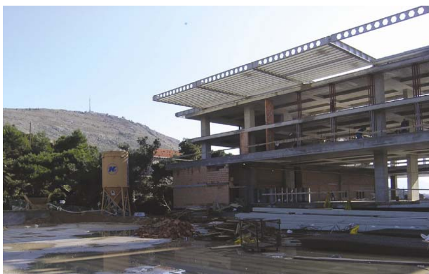
Završni radovi na novom glavnom ulazu
