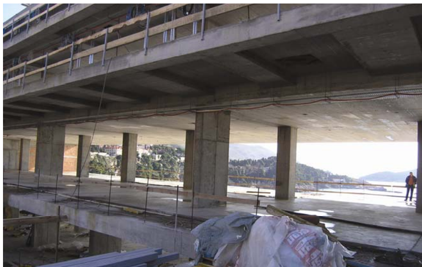
Radovi na prizemlju bloka A
