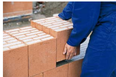
Gradnja opekom Poroton T9
