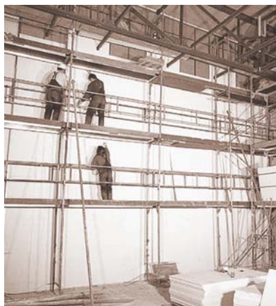
Montaža visokoga zida od gipskartonskih ploča
