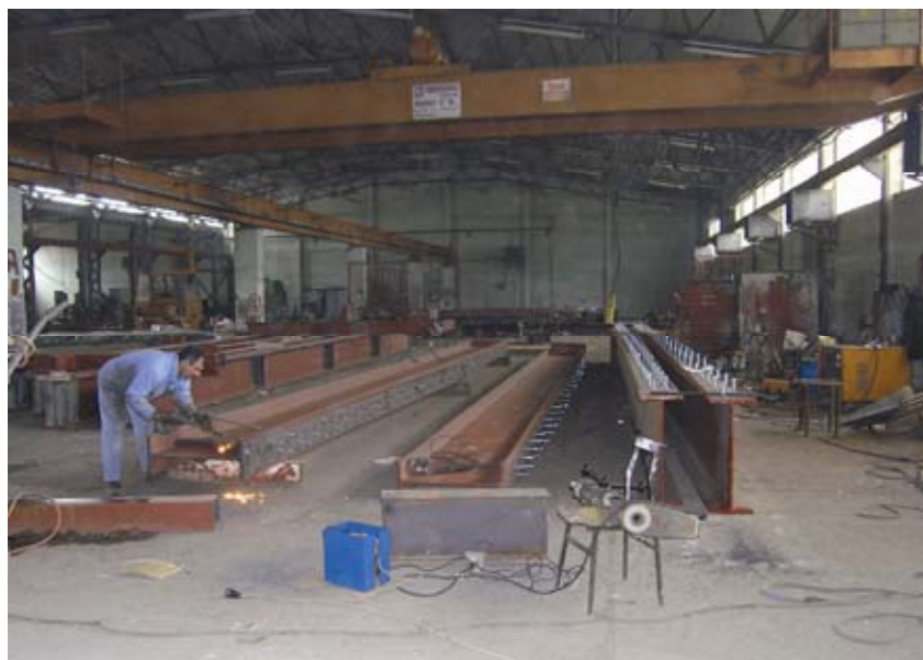
Izrada čeličnih nosača u radionici
