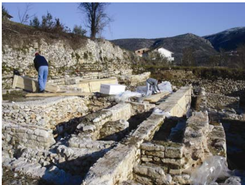
Zaštićivanje arheoloških ostataka prije početka radova
