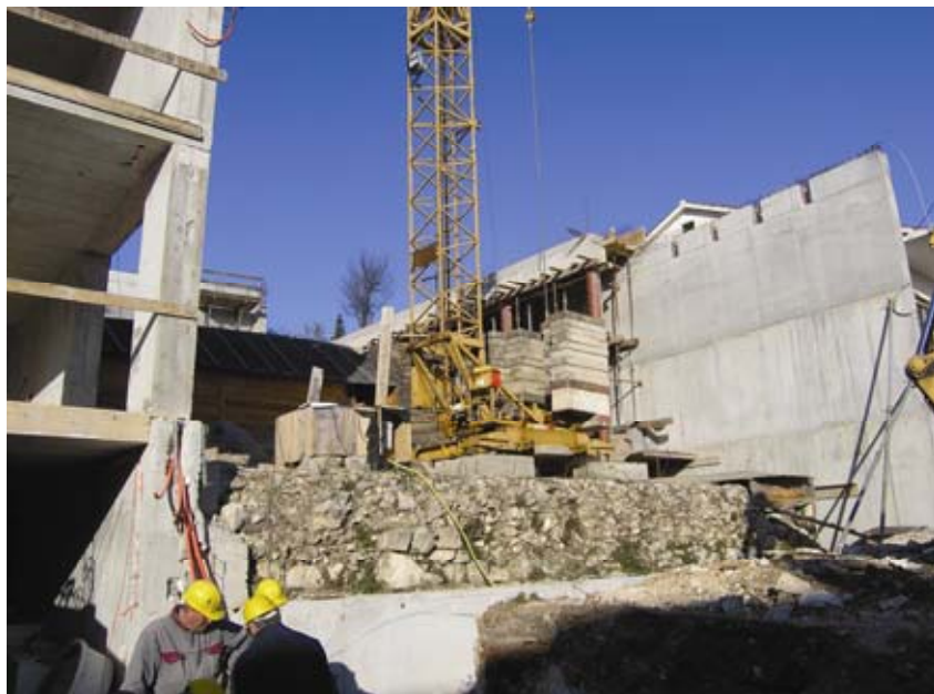
Detalj s gradilišta iz siječnja 2006.
