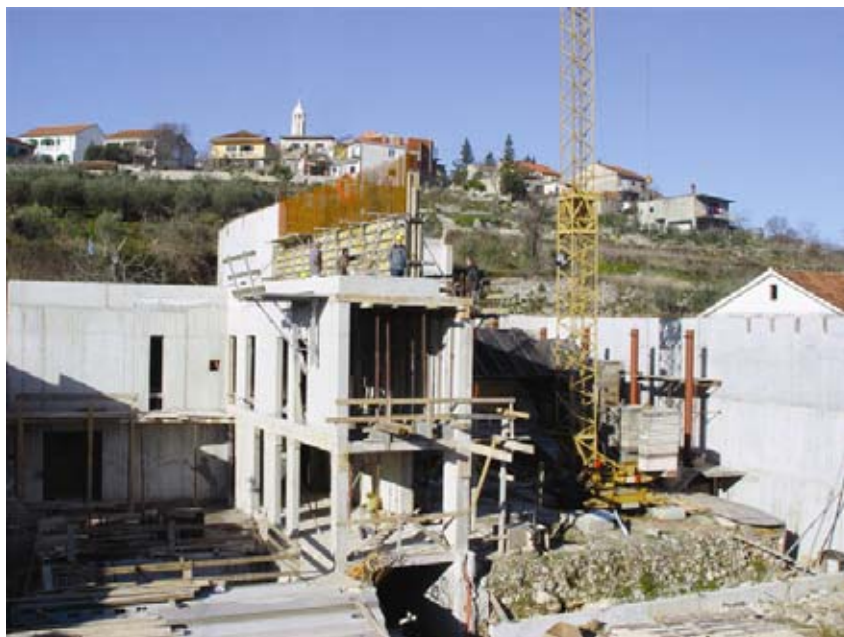
Pogled na gradilište krajem 2005.
