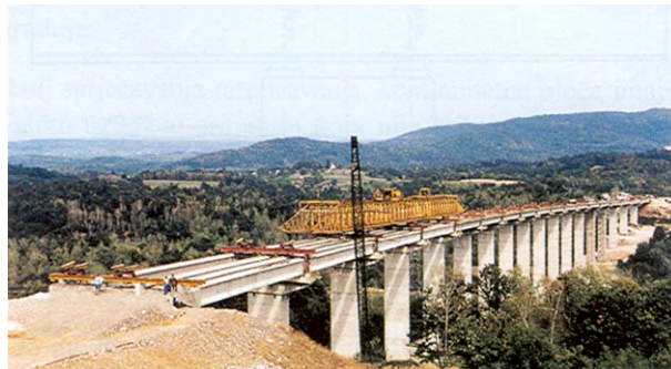
Slika 5. Izgradnja vijadukta "Severinske drage"
