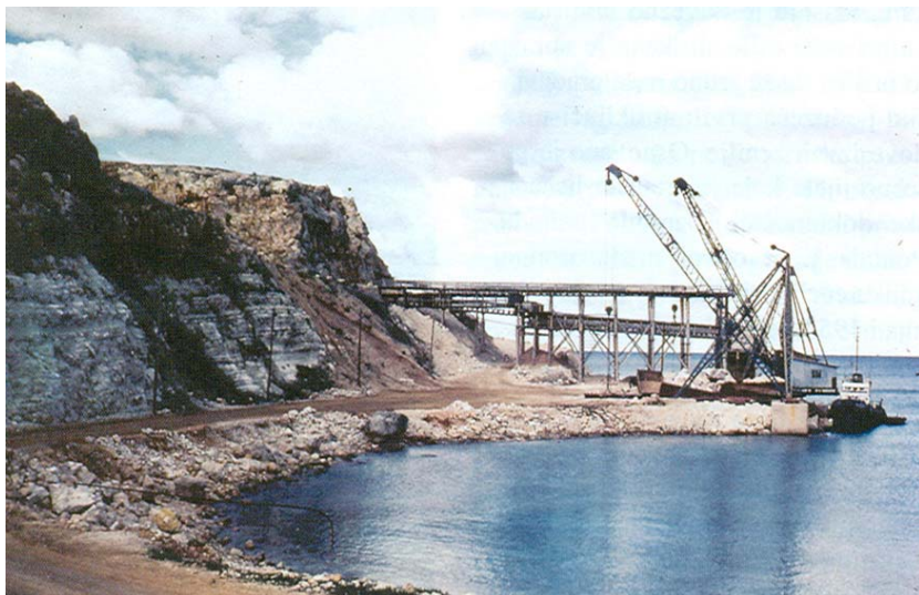
Mjesto utovara u tegljenice sa stabilnom dizalicom
