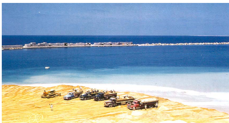
Nasipanje pijeska za gradnju obale
