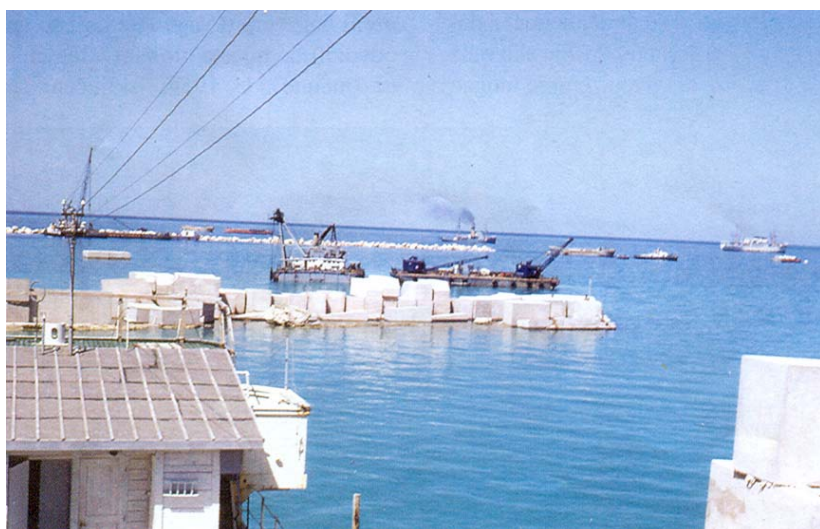
Ugradnja betonskih blokova
