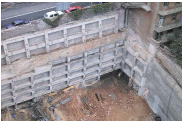
Slika 3. Pokos "Sjever" i "Istok" u fazi iskopa na koti +5.00
