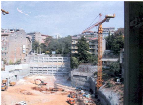
Slika 5. Pogled na građenu jamu tijekom izvedbe
