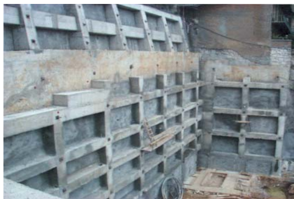
Slika 4. Pokos "Sjever" i "Istok" u fazi iskopa na koti dna građevne jame
