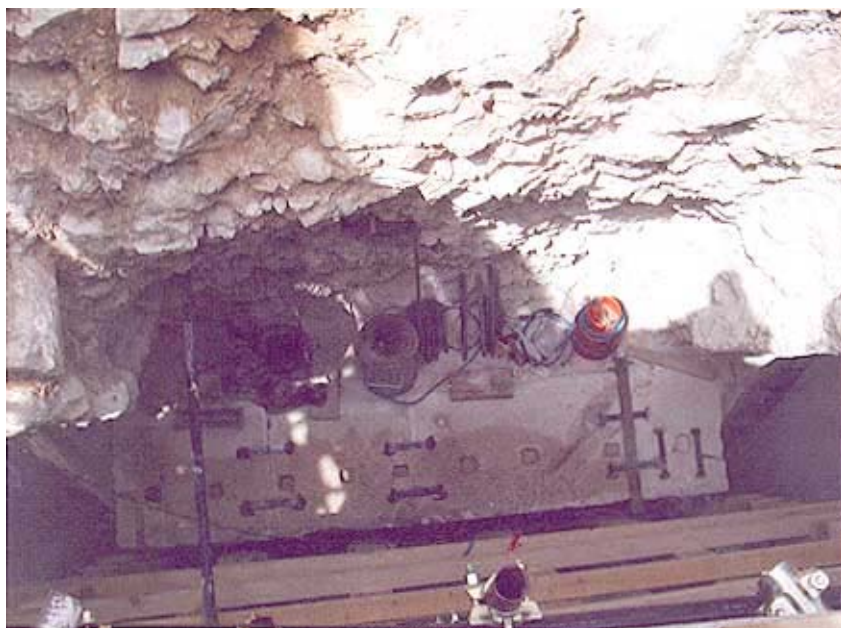
Ugradnja prvih kamenih blokova
