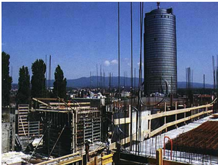
Zapadni dio zgrade u gradnji
