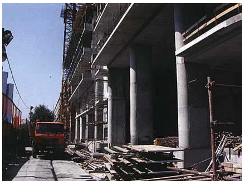
Dio gradilište uz Savsku cestu
