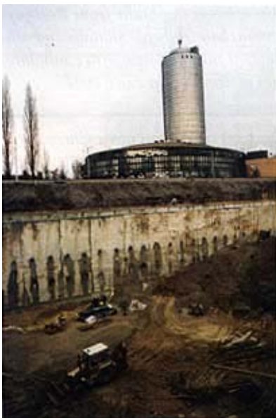
Radovi u građevnoj jami
