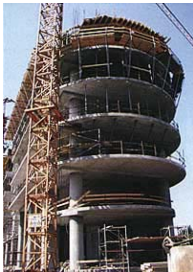
Pogled na gradilište sa sjeverne strane
