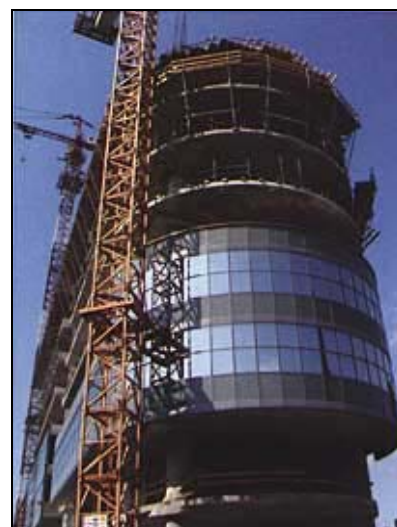
Početak oblaganja pročelja
