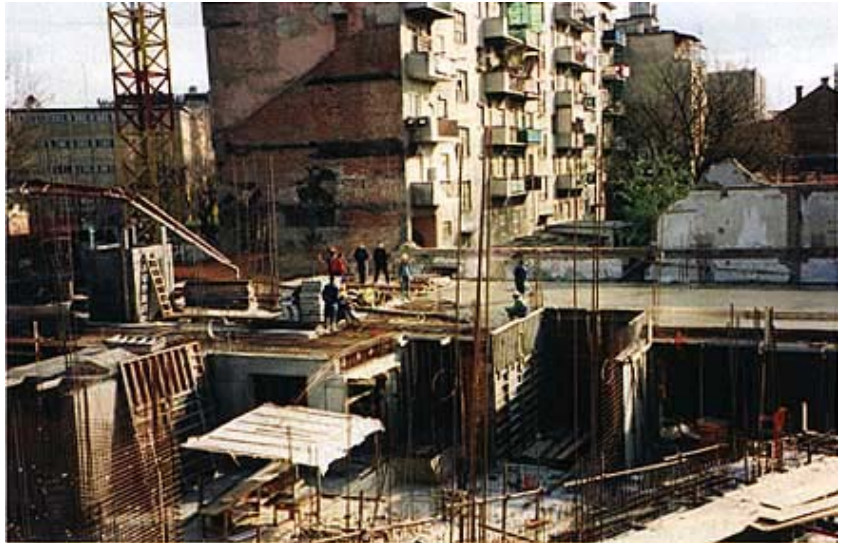
Gradilište u fazi radova do razine prizemlja
