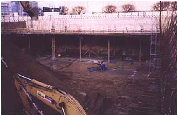
Slika 8. Iskop na razini -3
