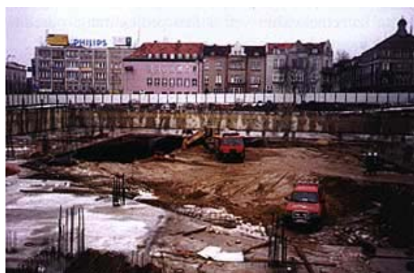
Slika 7. Iskop na razini -1. Podni prsten -1 (ostatak poda izveden je u sljedećoj fazi radova)
