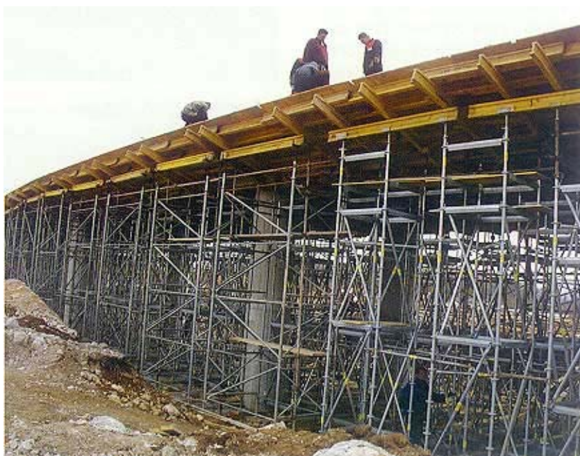
Radovi na čvorištu Sv. Rok
