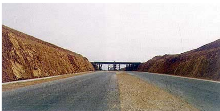
Pogled na gradilište nadvožnjaka u usjeku na dionici Sv. Rok – Maslenica
