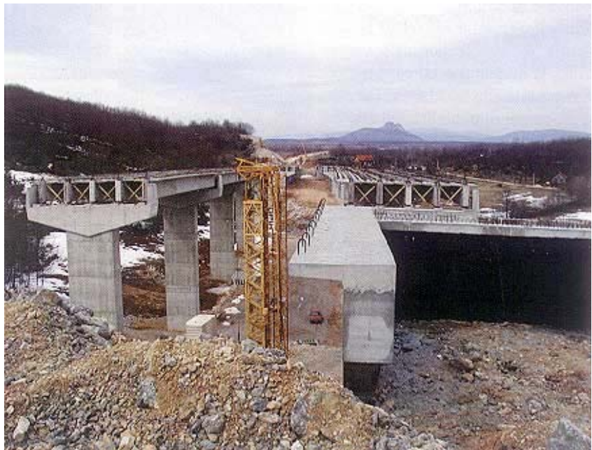
Gradilište vijadukta Krpani
