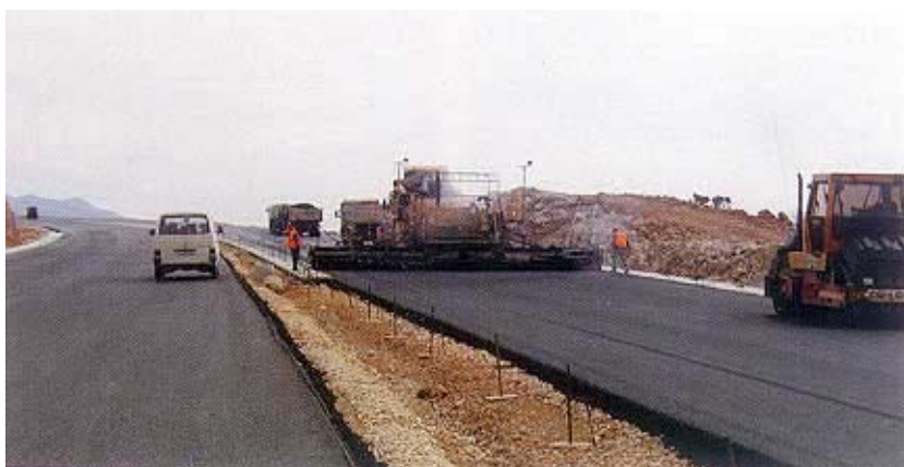
Asfaltni radovi na dionici Sv. Rok - Maslenica
