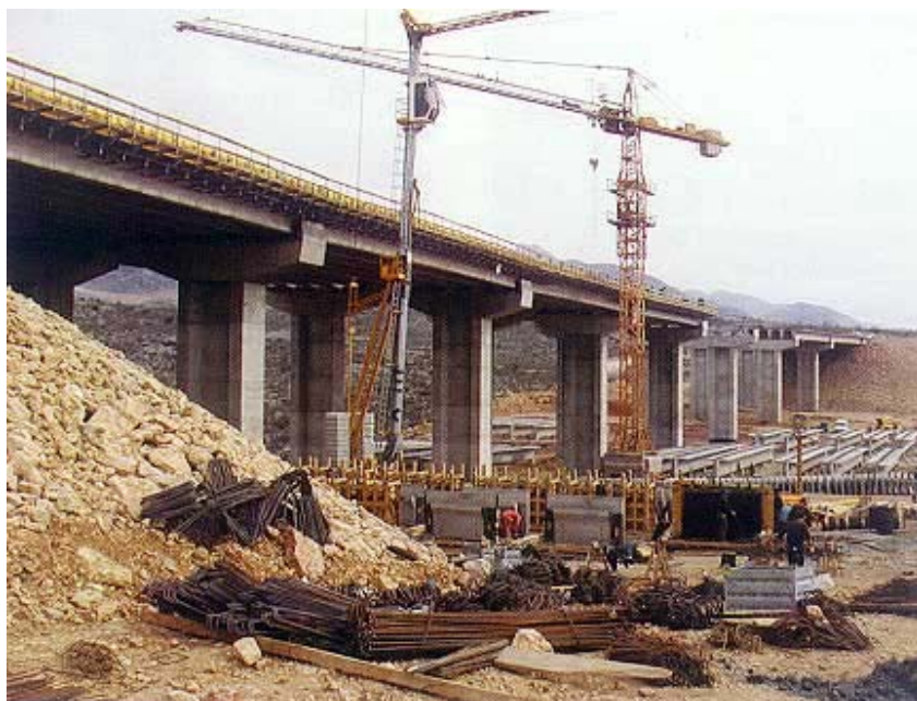
Gradilište vijadukata Božići
