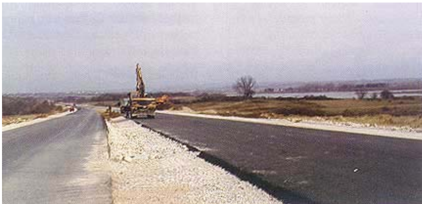
S trase u izgradnji na dionici Zadar 1 – Zadar 2
